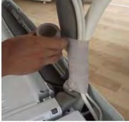
Boruların dekoratif bantla sarılması
