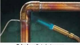
Bakır boru ile tesisat yapımı
