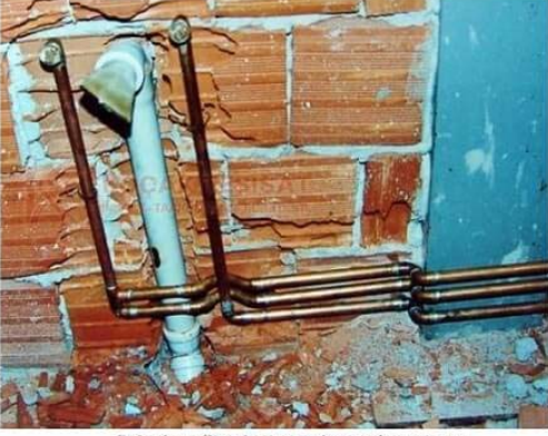
Bakır boru ile ankastre temiz su tesisatı yapımı
